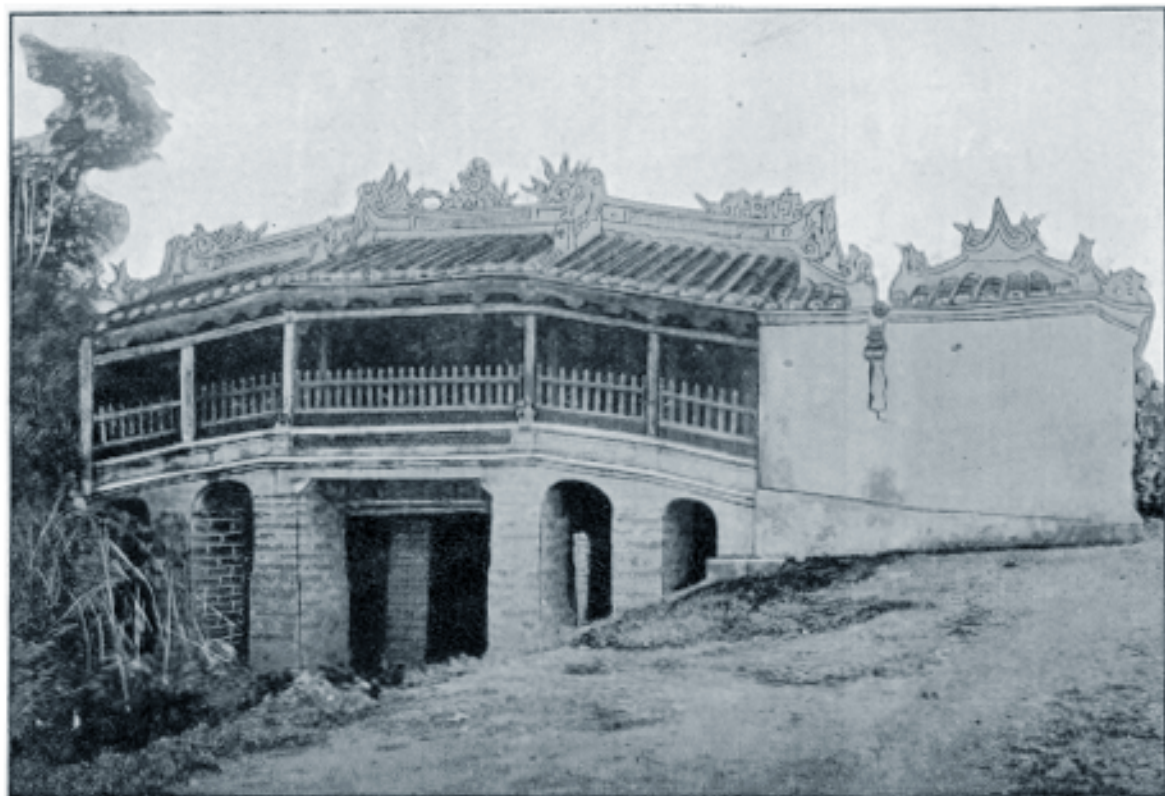
Planche XXVII. — Le pont japonais, à Faifo : vue d'ensemble, du côté Sud.
